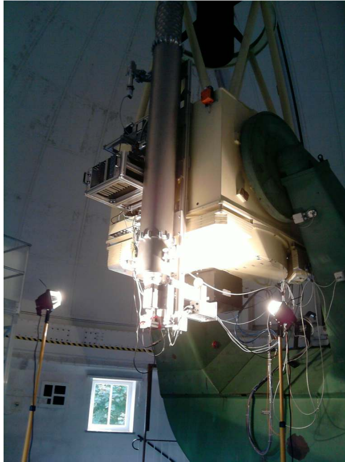
ABBILDUNG 5.1: Systematisch entlang der gesamten Röhre wurden mit leuchtstarken Halogenstrahlern die diversen Übergänge der Röhre genauer und punktuell auf ihre Lichtdichtigkeit getestet.
