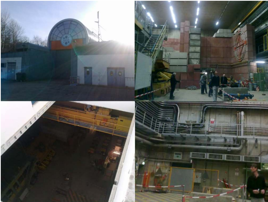
ABBILDUNG 8.11: Eindrücke der Zeus-Halle des alten und leerstehenden Hera-Beschleunigerrings. Durch einen Lichtschacht und mit Hilfe eines vorhandenen Krans hätten die Bauteile von TSHIPS 3 sicher in die unterirdische Halle gebracht und dort montiert werden können.
