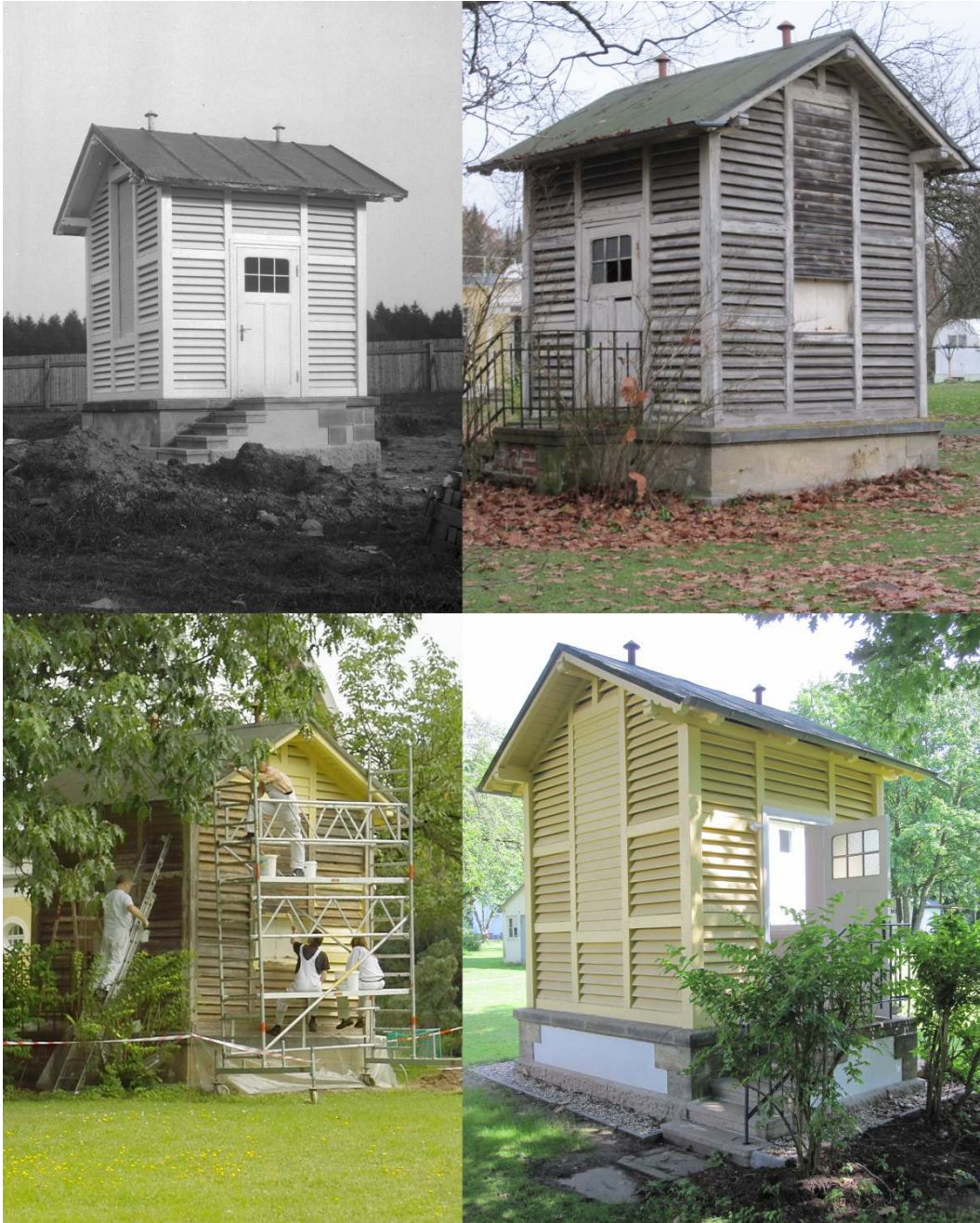
ABBILDUNG 8.5: Zustand des Mirenggebäudes zum Zeitpunkt des Baus sowie vor, während und nach den Sanierungsarbeiten. Alle baulichen Maßnahmen wurden unter Berücksichtigung der Auflagen des Denkmalschutzes umgesetzt.
