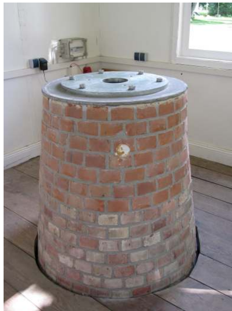
ABBILDUNG 8.4: Zentrales Ringfundament mit Adapterplatte der renovierten Mire. Es hat eine Gesamthöhe von 4,5 m, wobei nur das oberste Ende sichtbar ist. 2,5 m des Fundaments befinden sich im Erdreich, wodurch ein sehr stabiler, schwingungsfreier Sockel entsteht - ideal als Basis für ein SHIPS-Helioskop.
