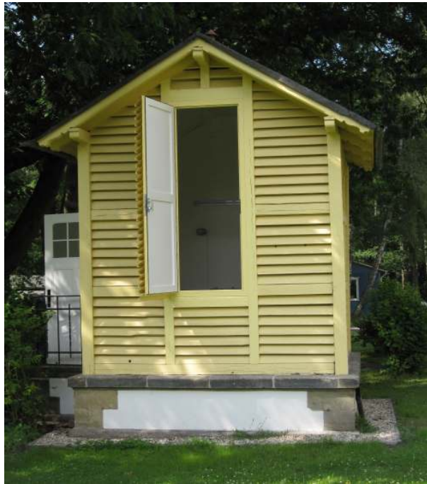
ABBILDUNG 8.3: Wie im ursprünglichen Entwurf der Mire etwa aus dem Jahre 1910, ist auch nach der Sanierung des Gebäudes wieder eine seitliche, verschließbare Öffnung gegeben. Diese war zwischenzeitlich verschlossen worden, nachdem der Meridiankreis außer Betrieb ging. Durch die Öffnung ist eine direkte Sichtachse aus dem Meridiankreisgebäude in das Innere des Mireng Gebäudes gegeben.
